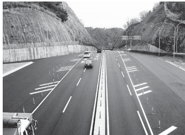
料金所跡 再整備後
