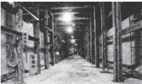
写真-2 側壁盛替え工法施工状況写
