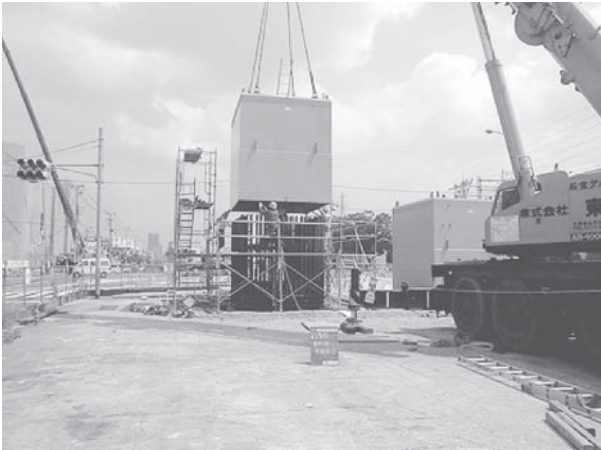
鋼-コンクリート複合構造の建設状況
